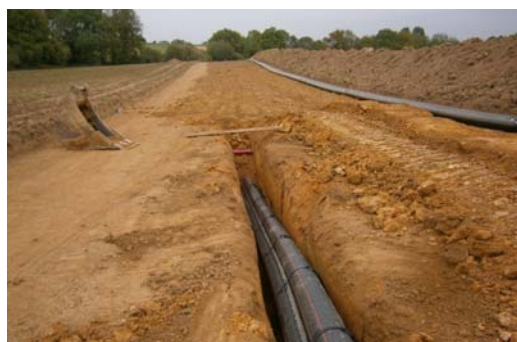
Figure 16 : Un exemple de pose d'une liaison souterraine : sous voirie à gauche ; en plein champ à droite (RTE)
