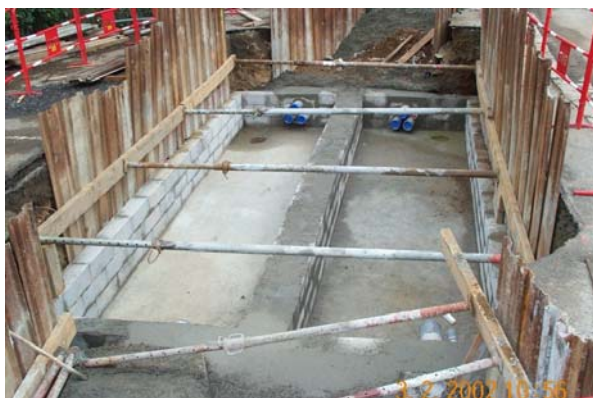
Figure 17 : Un exemple de chambre de jonction : sous voirie à gauche ; en plein champ à droite (RTE)
