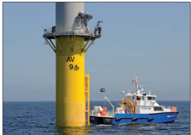
Figure 20 : Un exemple de navire de maintenance (Technip, 2013)
