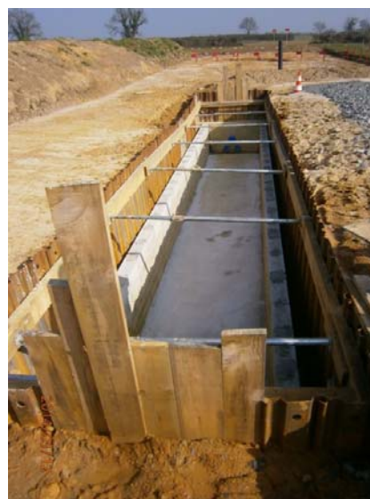
Figure 17 : Un exemple de chambre de jonction : sous voirie à gauche ; en plein champ à droite (RTE)
