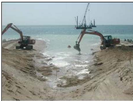
Figure 15 : Un exemple de travaux de tranchée à l'atterrage (RTE)
