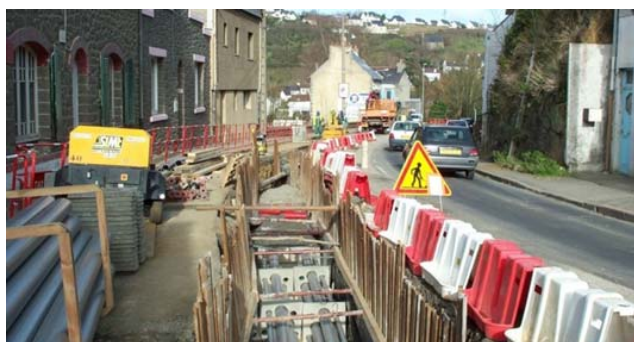
Figure 16 : Un exemple de pose d'une liaison souterraine : sous voirie à gauche ; en plein champ à droite (RTE)
